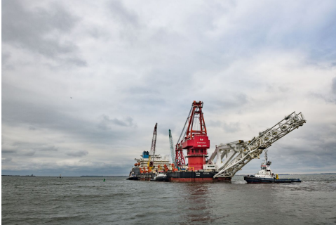
Pijpenlegger Fortuna verlaat de haven van Wismar © Sputnik / Dmitry Lelchuk -
