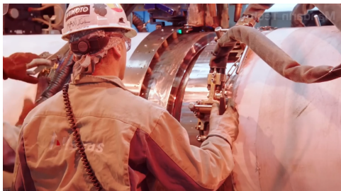
Un soudeur du Fortuna met en place la soudeuse automatique
